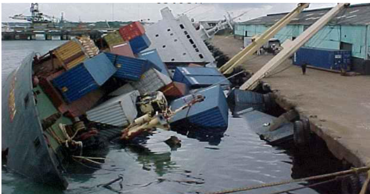
Figura 8.9: Ejemplo de daños imprevistos.
